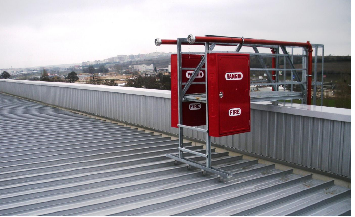
Çatıda merdiven ayak montaj uygulaması
