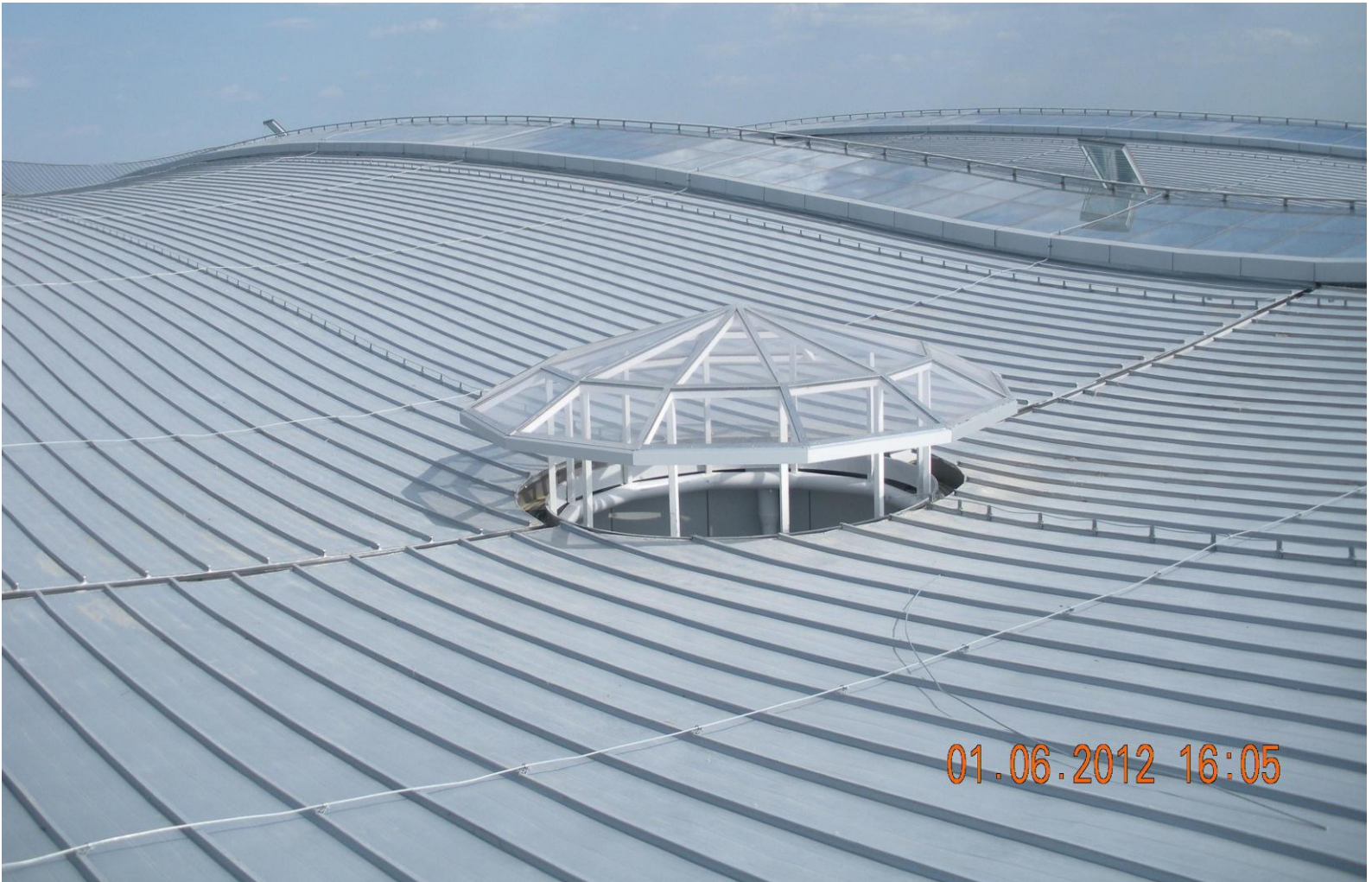
BORYSPİL /KİEV ULUSLAR ARASI HAVA LİMANI /TERMİNAL BİNASI / KASET İÇİ TAŞYÜNÜ ÜZERİ 45/475 KAYNAKLI BİRLEŞİM KENET PANEL
